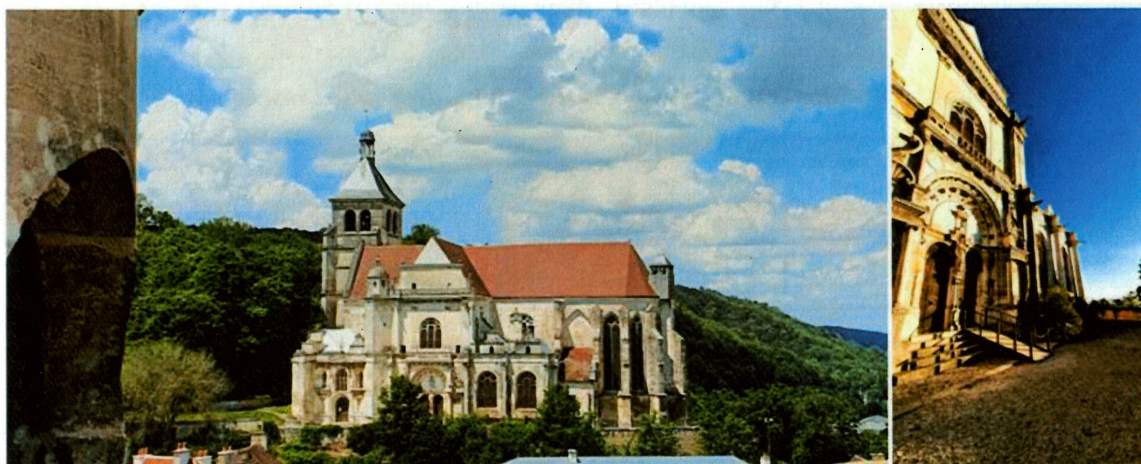
Photo n° 6 : Eglise Saint-Pierre de Tonnerre
