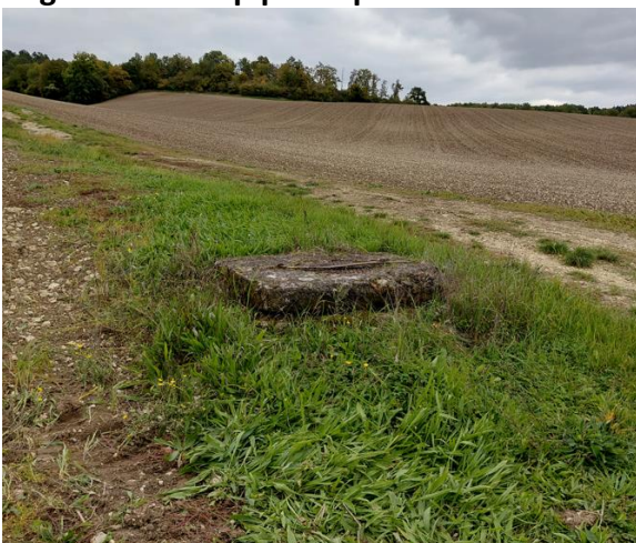
Regard avec trop plein qui vient alimenter un ru
